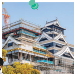
復旧が進む熊本城天守閣の「大天守外観復旧」を記念して、秋から特別公開(第1弾)が開始予定です。
